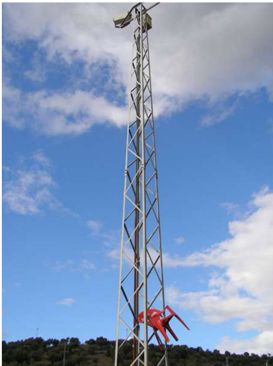
Image d'un pylône
